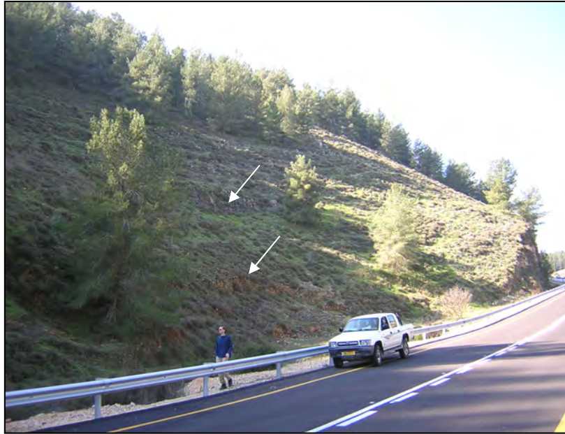
איור 12. גלישת סלע בגדה הדר-מזרע של נחל יראון. בסלעי תצורת בר-כוכבא (גובה 100 מ', רוחב 200 מ'). בחלק התחתון של הגלישה מתפתחות גלישות רוטציוניות קטנות (רוחב וגובה מטרים) בתוך חומר המדרון (מסומן בחץ).
